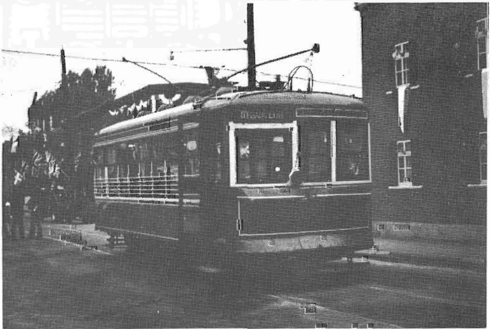
Le tram 200 sur le rue Hibernia.
