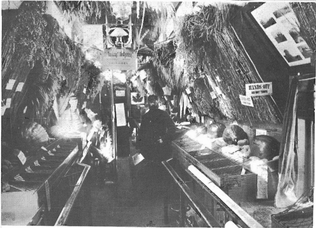
Le Canadien Pacifique menait également sa propre campagne de colonisation. Le fourgon no. 303 transformé en musée agricole servait à inciter l'établissement de nouveaux colons sur les terres de l'ouest du pays.
