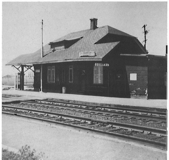
Vue générale de la gare de Dorval le 3 juin 1985 à 2 h30 p.m.. À noter que cette gare sera vraisemblablement démolie pour faire place à gare tran-autobus et à un stationnement.
