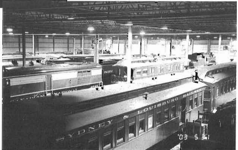
Vue plongeante prise de la mezzanine le 31 Mai 2003. (FA)
