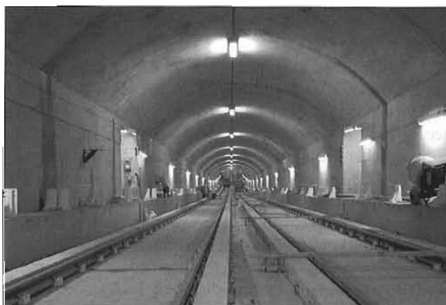
A completed section of double track tunnel. Une section terminée du tunnel à double voie.
