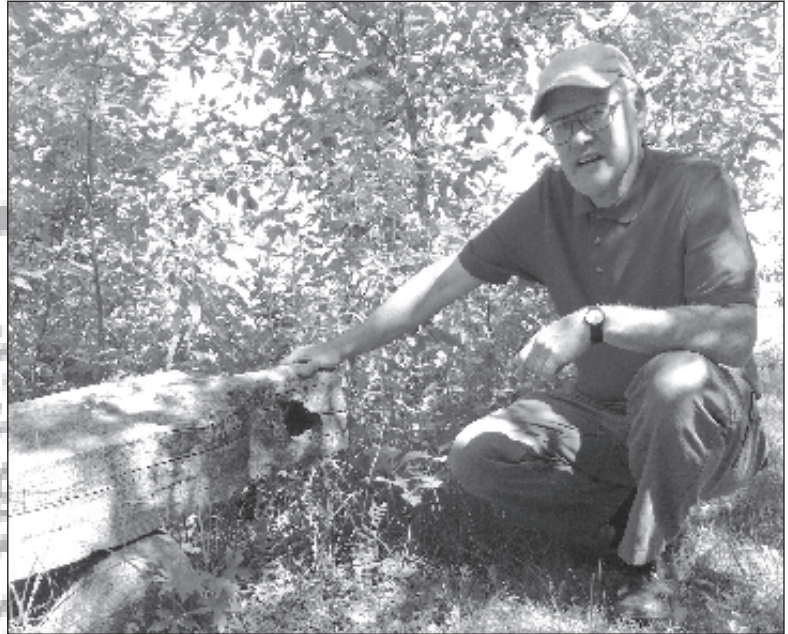
George Parker, récemment photographié près d'une pièce de bois provenant d'une jetée, échouée sur l'île de Tic; à noter la queue d'aronde avec un trou pour recevoir une tige de verrouillage. Pauline Browse (propriétaire de l'île de Tic)
