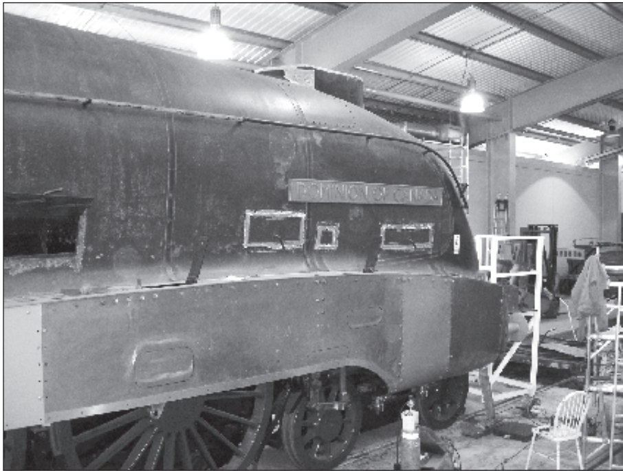
Restoration in progress, Jan. 2013 / La restauration progresse. Janvier 2013
