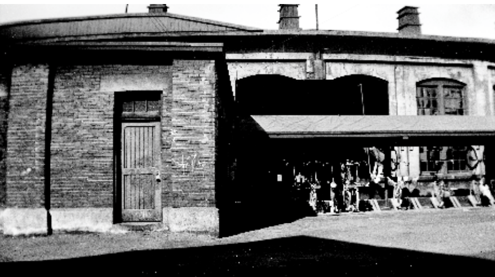
Les rapiécés noirs sur le mur de la rotonde indiquent l'endroit où la locomotive 2545, une 2-8-0, ne s'est pas arrêtée et a démolie le mur. Par la suite, des réparations plus approfondies furent complétées, briques et fenêtres ajoutées. En avant-plan, le support à bicyclettes révèle que plusieurs employés se rendaient au travail par ce moyen quand la photo fut prise en 1948. Ernest Modler
