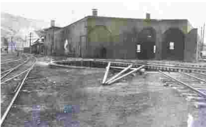
Photo 50: Four stall engine house with turn table probably at St. John's. La rotonde de quatre stalles avec le pont tournant, probablement à St. John's
